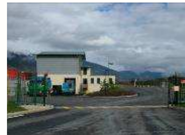
Quai de Transfert de Crozet
