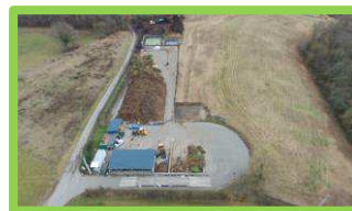
5 - Plateforme compostage Baraty
